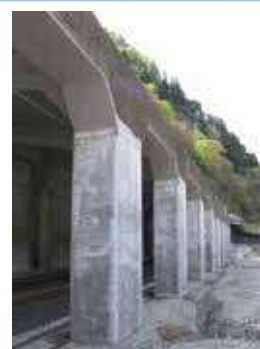
柱補修の事例
