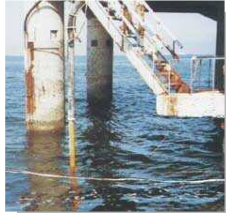
海上灯台改修工事(柱・基礎部打設)
