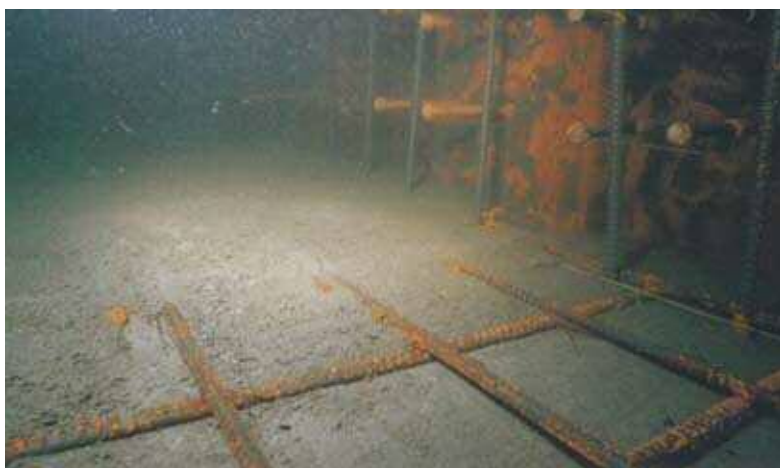
排水路底部(水中)打設状況
