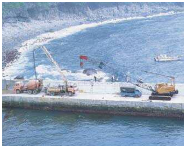
防波堤洗掘部施工状況
