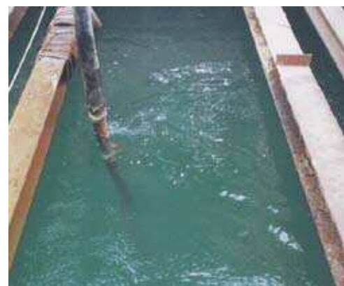
排水路補修工事(流速1.8m/sec)
