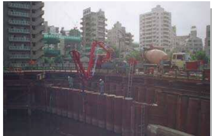
石神井川護岸改修工事
