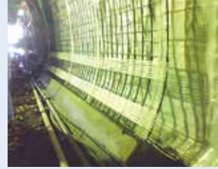
トンネル覆工
