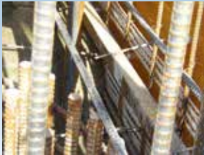
壁面のコンクリート打設状況
