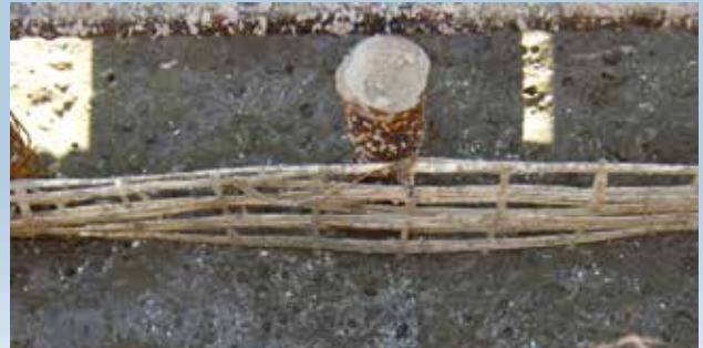
コンクリートの壁面の打ち込み状況
