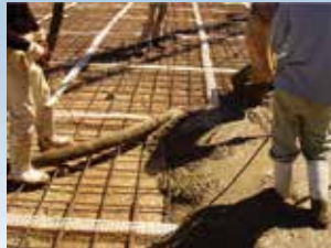
土間のコンクリート打設状況
