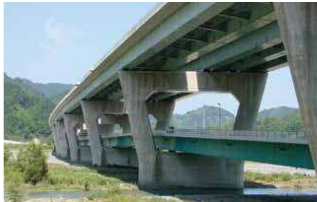
第二東名高速道路 安倍川橋 床版コンクリート
