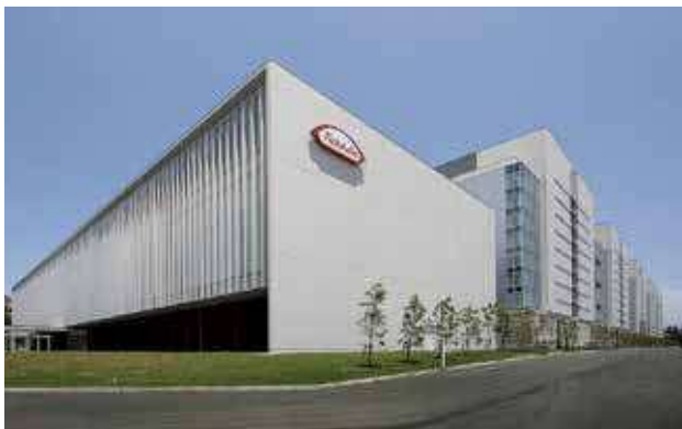
研究施設 スラブコンクリート
