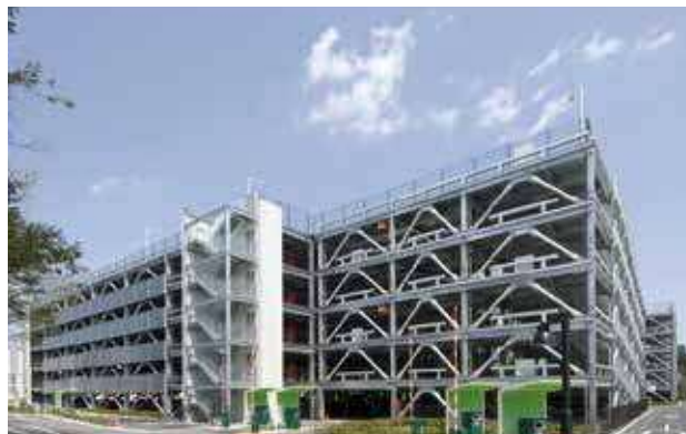
立体駐車場 スラブコンクリート
