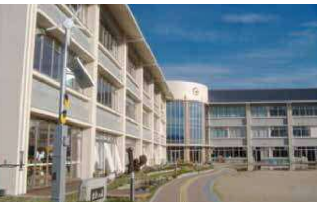
小学校校舎 建築躯体コンクリート
