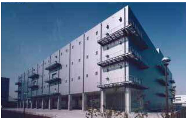
物流倉庫 スラブコンクリート
