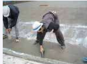
硬化前の養生
