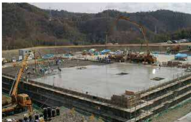
浄水施設 躯体コンクリート
