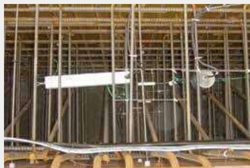
現場写真(計器取り付け)
