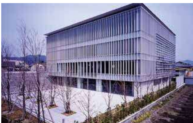
大学校舎 建築躯体コンクリート
