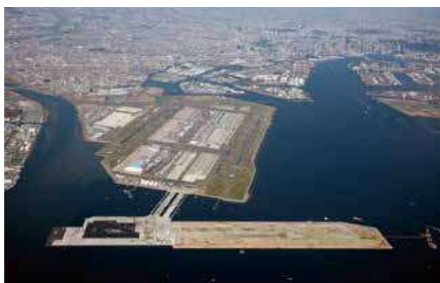
羽田空港拡張工事D滑走路 床版間詰めコンクリート
