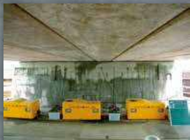
内部圧入工 (ASRリチウム工法)
