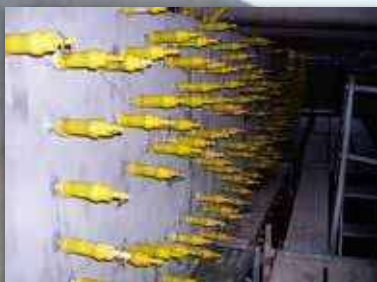
ひび割れ注入 (低圧注入工法)
