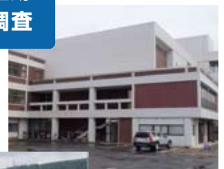
中性化対策補修 実施後31年経過
