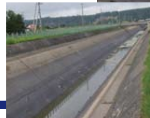
凍害対策補修 実施後19年経過
